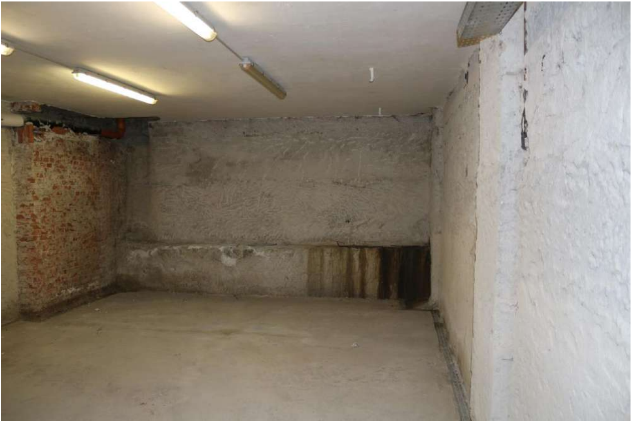
FOTO n°9. - visione interna tipo – piano interrato
