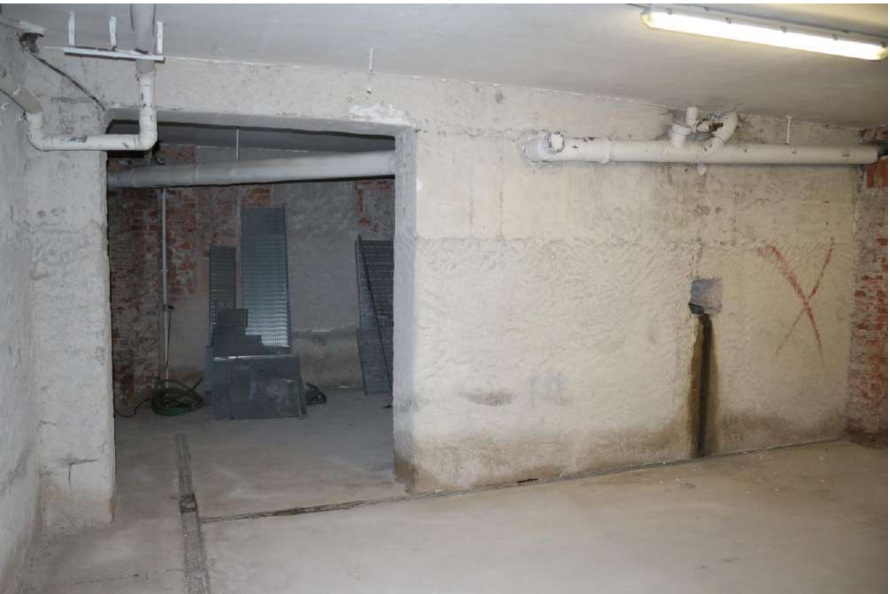
FOTO n°8. - visione interna tipo – piano interrato
