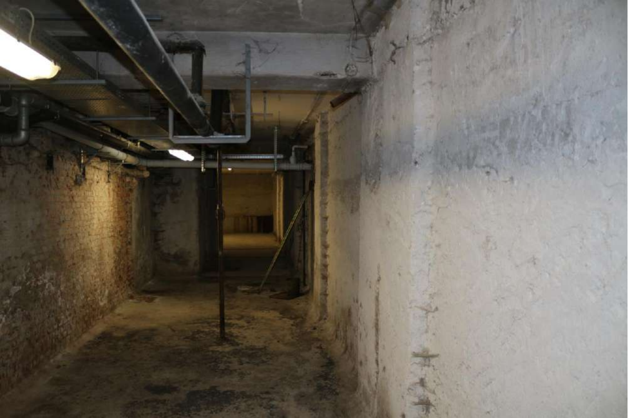
FOTO n°7. - visione interna tipo – piano interrato
