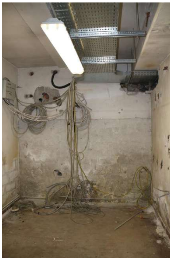
FOTO n°6. - visione interna tipo – piano interrato
