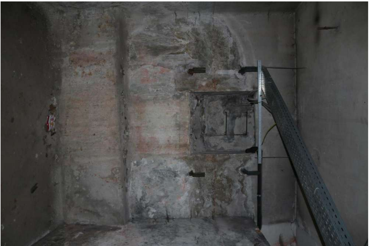
FOTO n°10. - visione interna tipo – piano interrato
